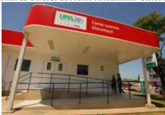
Figura 3 – Vista frontal da Unidade de Pronto Atendimento Carlos Loureno Giacomazi
